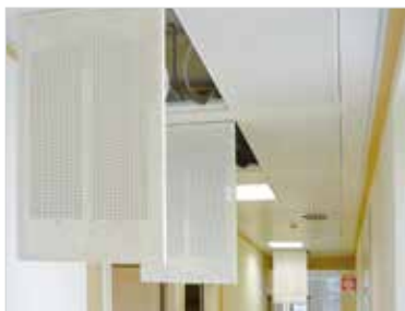
Inspecionabilidade do teto radiante metálico
