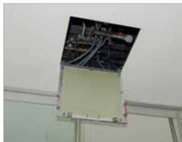
Inspecionabilidade do teto radiante em cartão gesso
