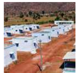
Colaboração com a Fundação Vicente Ferrer na construção de casas para pessoas vulneráveis em Anantapur, Índia.
